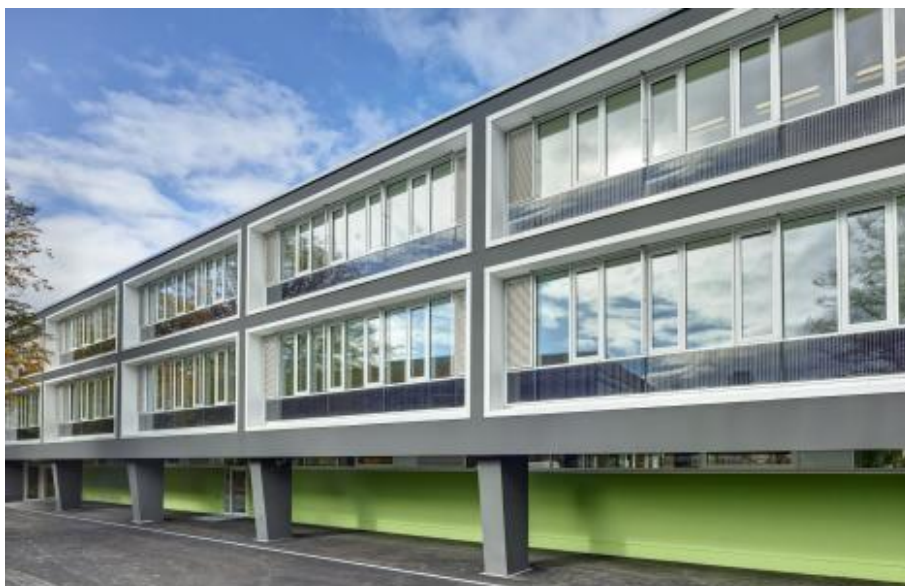
Фигура 10: Фотоволтаични модули в зоната на парапета на южната фасада на училище Ухланд в Щутгарт.
